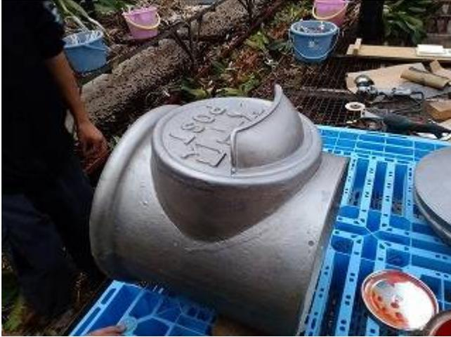
パーツは全て組み上げながら、パーツ間の隙間は元のようにパテを使い完全になくします。その後サビキラーを3回重ね塗りしました。
